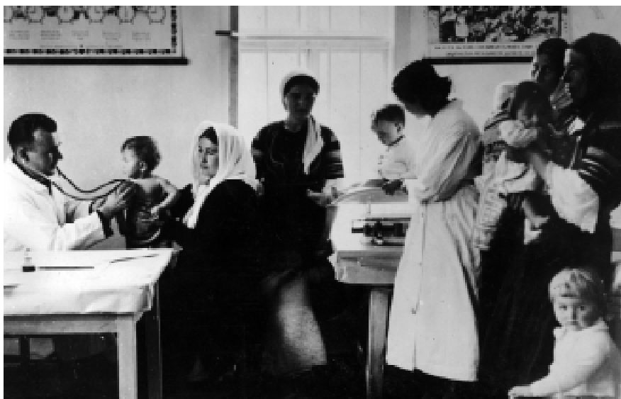
Здравно-съвещателна станция, с. Дивля, ЦДА, ф.3к, оп. 15, а.е. 241
